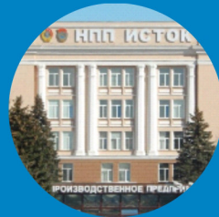
Завод «Исток» г. Фрязино ул. Вокзальная 2А, к.1 ИТП и Система отопления
